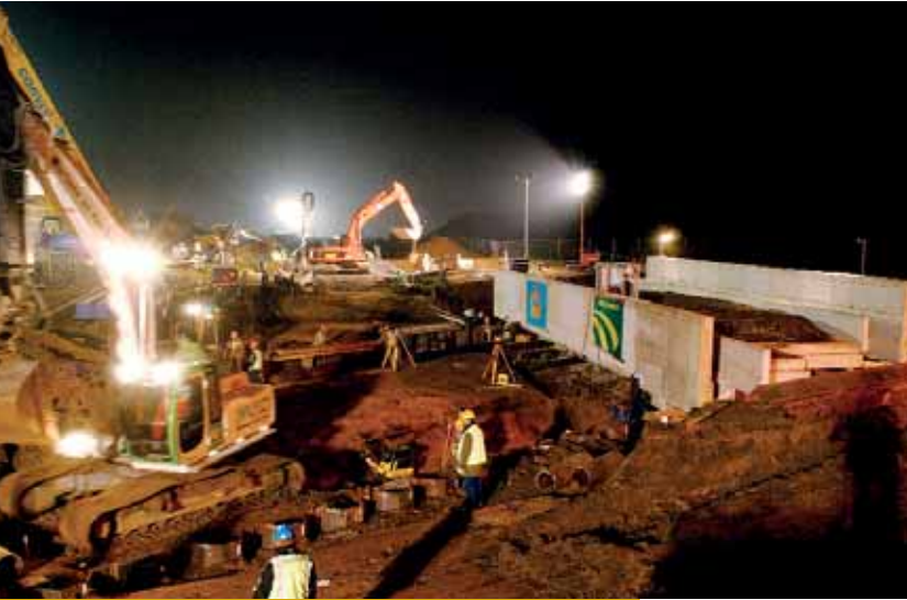
IN VOORBEREIDING OP DE WERKZAAM- HEDEN WORDT HET SPOORVIADUCT OVER DE ASSELSTRAAT VERPLAATST.
